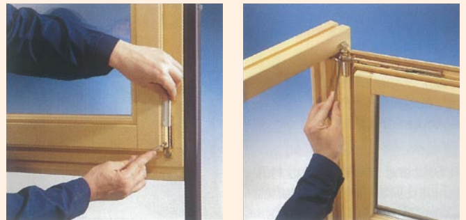
Bei der Wartung werden die Beschlagteile, die Gummidichtungen und der Allgemeinzustand des Fensters (Holz, Farbe, Lack, Silikon) inspiziert.
